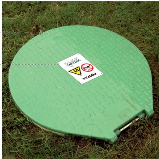
Alle Tankarmaturen befinden sich unter dem abschliessbaren Domschachtdeckel. Durch konsequentes Abschliessen wird sichergestellt, dass an den Armaturen keine Manipulationen durch Unbefugte erfolgen.
